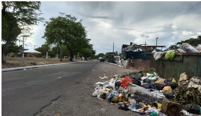
Figura 1 - foto da parte da Orla Lagunar com lixo, sem estrutura e falta de segurança
